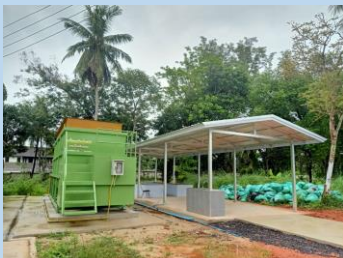
รูปที่ 8 เครื่องผลิตก๊าซชีวภาพ (ซ้าย) และเครื่องสับย่อยเศษใบไม้ (ขวา)
